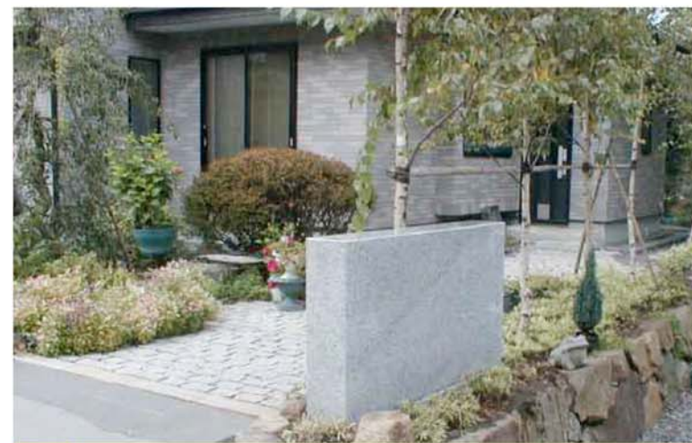
02 小舗石 90mm × 120mm × 180mm 門(台石付、稲田みかげ) 200mm × 1000mm × 1800mm 自然石石積み(野面)
